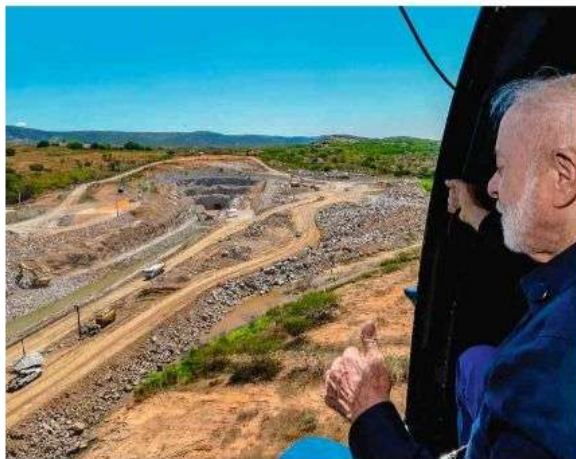
Presidente Lula sobrevoa Túnel Major Sales, na transposição das águas do rio São Francisco para o Rio Grande do Norte, via ramal do Apodi. Ricardo Stuckert/PH
