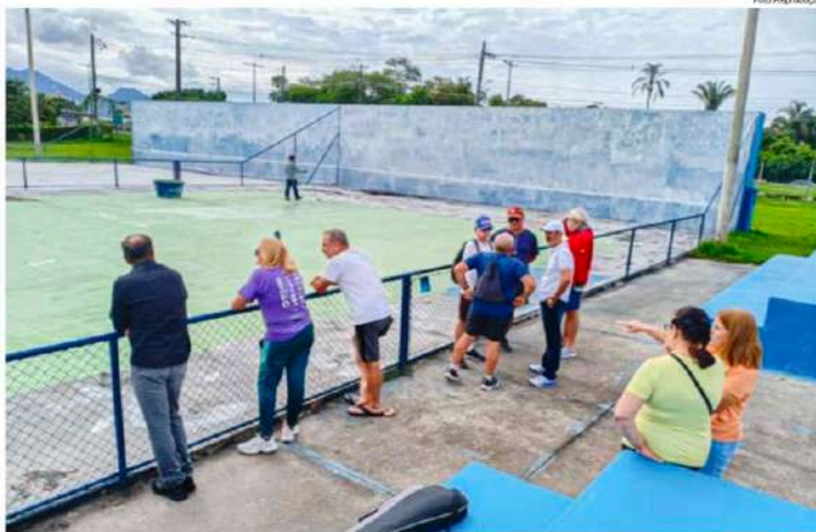
Usuários aguardam final de reforma para retomar atividades no Cemug; trabalho de recuperação é alvo de reclamações em Caraguatatuba
