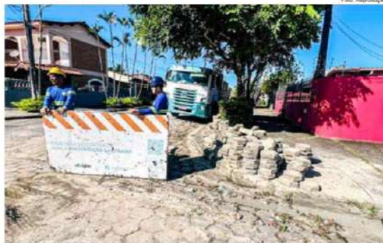
Obra da Sabesp, um dos apontamentos feitos para série de multas aplicadas pela Prefeitura de Caraguá
