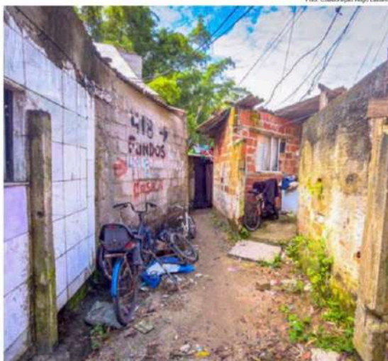
Casa em área de risco de Caraguá, que inicia trabalho que cadastra famílias em moradias com maior risco
