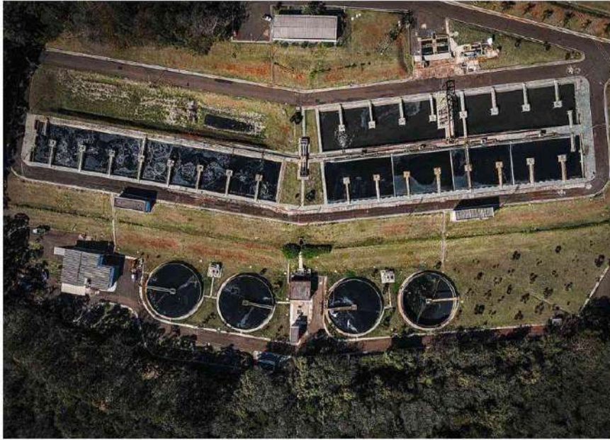
Estação de tratamento da Sabesp em Botucatu (SP); empresa de saneamento está no Índice Utilidade Pública Rubens Cavallari - 26. ago.25/Folhapress
