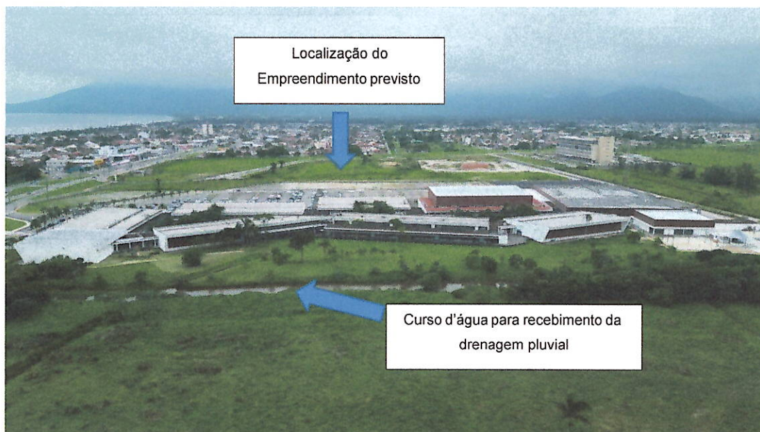
Figura 6: Curso d'água para recebimento da drenagem pluvial.
