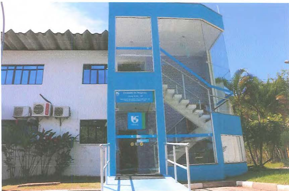
Foto 37: Fachada do Laboratório de Ensaio da Divisão de Controle Sanitário do Litoral Norte (RNOC).
