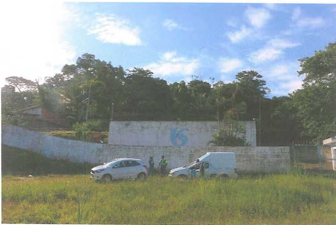
Foto 21: Sistema Guaxinduba – Reservatório Benfica, capacidade 1.750m 3 .
