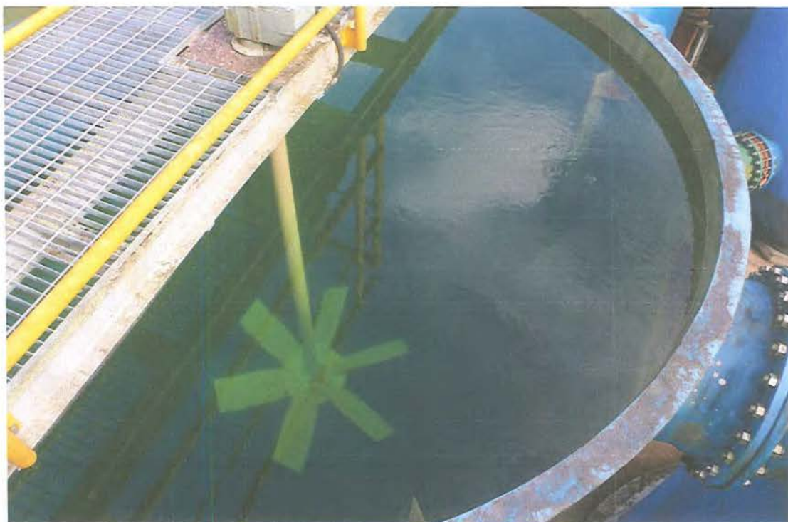
Foto 17: Sistema Guaxinduba – ETA – Detalhe da Turbina de Fluxo Axial.
