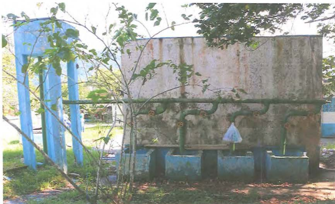
Foto 33: Sistema Tabatinga – ETA Tabatinga – Sistema de Filtrros.
