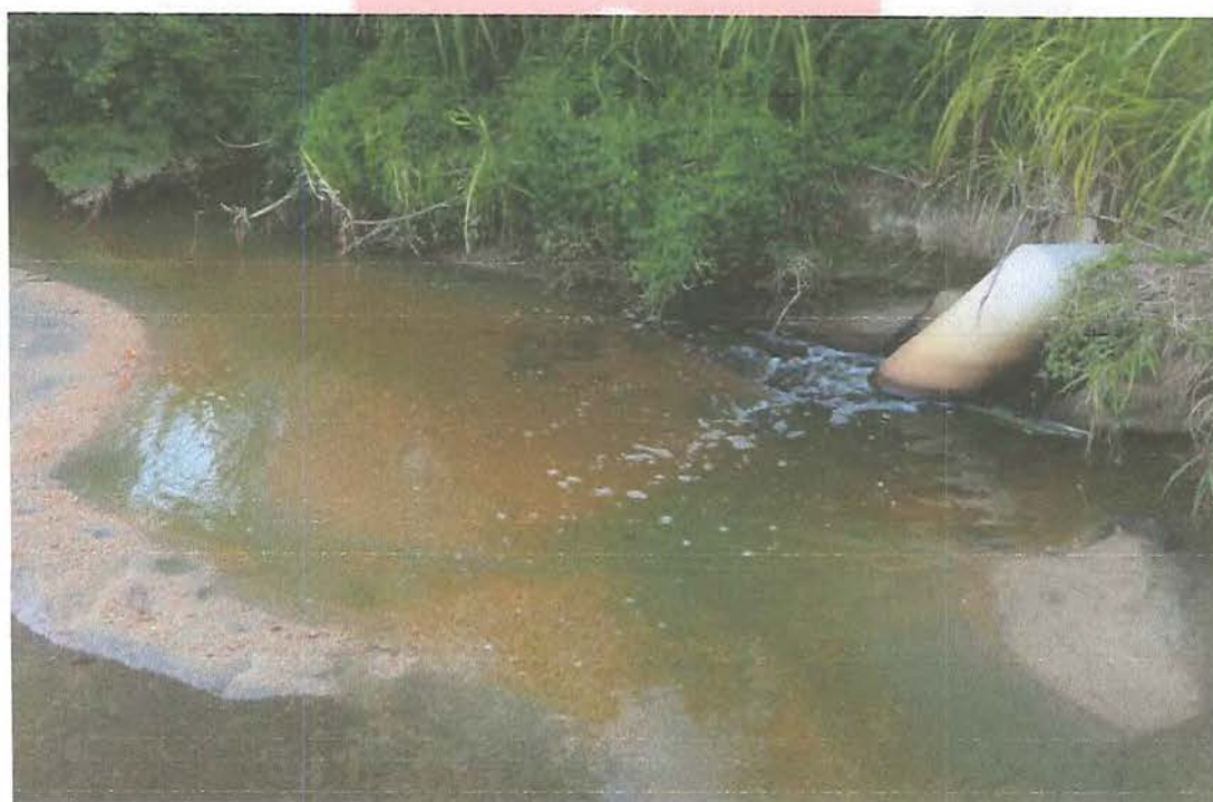
Foto 44: Corpo Receptor e ponto de lançamento do efluente tratado na ETE Martin de Massaguaçu (469769 E 7393360 S)
