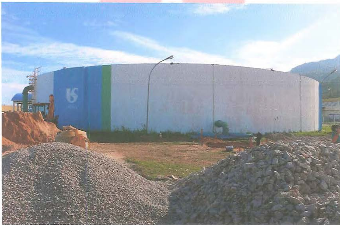
Foto 12: Sistema Porto Novo, Reservatório Palmeiras Norte.
