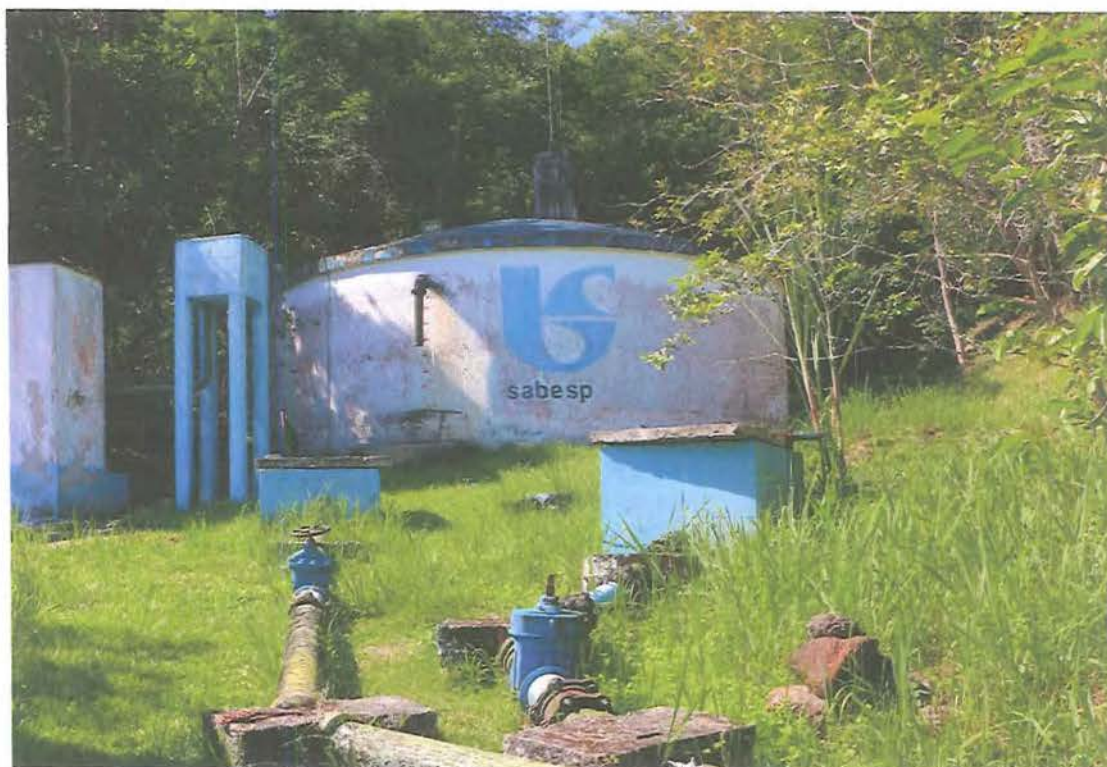
Foto 35: Sistema Tabatinga – Reservatório.
