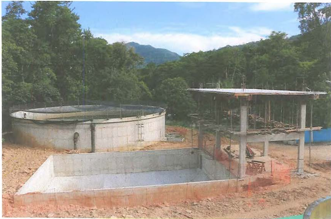
Foto 15: Sistema Guaxinduba – Implantação de Leito de Secagem e Unidade Administrativa.
