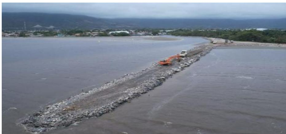
A Prefeitura de Caraguatatuba iniciou as obras do lado sul do enrocamento do Rio Juqueriquerê que vão formar o paredão de pedras, responsável por impedir a erosão das margens e dissipar a força das ondas no local.
