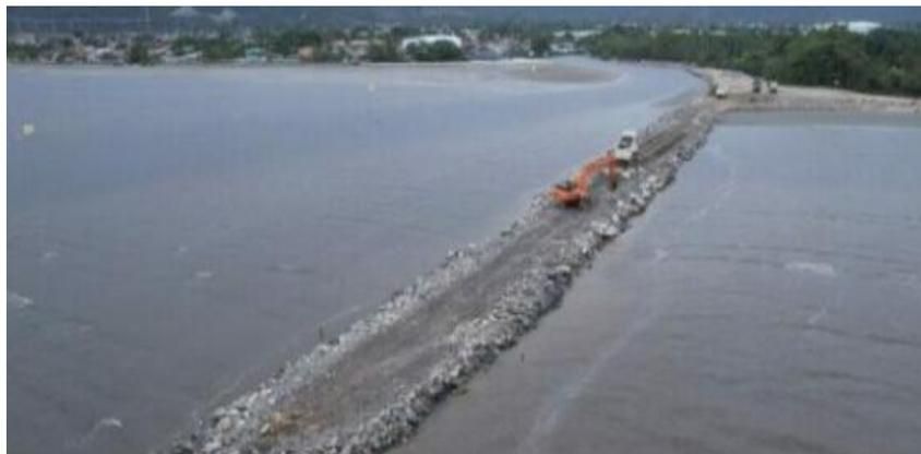
A Prefeitura de Caraguatatuba iniciou as obras do lado sul do entroncamento do Rio Juqueriquerê que vão formar o paredão de pedras, responsável por impedir a erosão das margens e dissipar a força das ondas no local.
