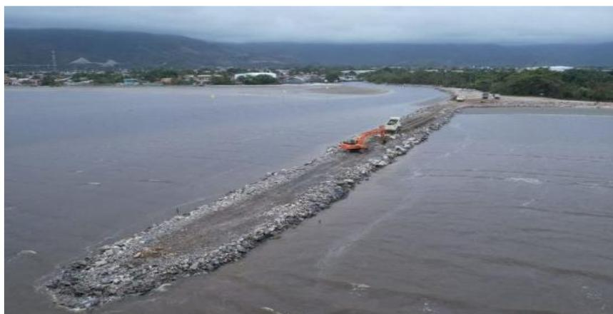
A Prefeitura de Caraguatatuba iniciou as obras do lado sul do enrocamento do Rio Juqueriquerê que vão formar o paredão de pedras, responsável por impedir a erosão das margens e dissipar a força das ondas no local.
