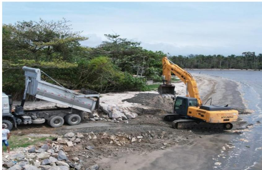
A Prefeitura de Caraguatatuba iniciou as obras do lado sul do enrocamento do Rio Juqueriquerê que vão formar o paredão de pedras, responsável por impedir a erosão das margens e dissipar a força das ondas no local.
