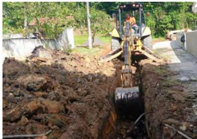
A operação visa instalação de 70 metros de tubulação e manutenção da via, para o recebimento de rede de drenagem da Rua Um do Recanto Verde Mar. Segundo a Sesep, a rua que faz interligação com outras vias, tem sofrido prejuízos com as fortes chuvas, causando alagamentos, devido ao entupimento da passagem da rua.
