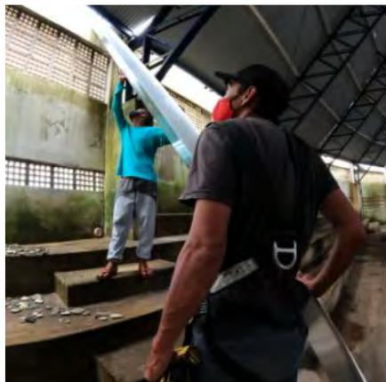
A empresa terceirizada contratada pela Prefeitura executa a implantação de um novo sistema de calhas para evitar infiltrações no local.
