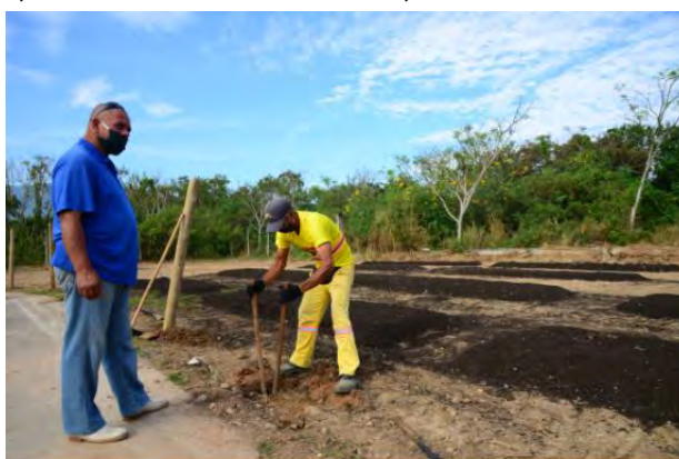
#PraCegoVer: Dois funcionários da prefeitura estão no terreno onde um cava a terra e outro observa (Foto: Divulgação/PMC)
