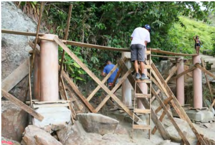
#PraCegoVer: Obra sendo realizada ao longo da trilha que sai da Prainha até a Pedra do Jacaré. Dois homens aparecem na construção (Foto: Divulgação/PMC)
