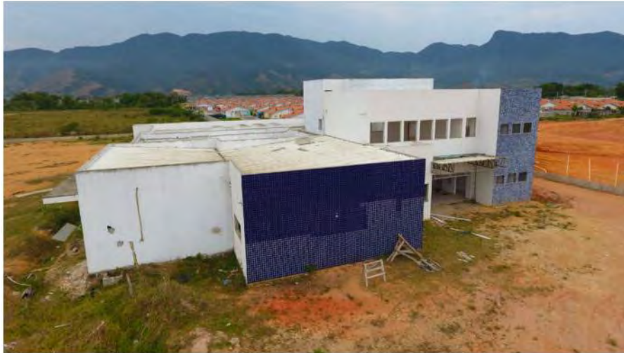
Construção da UPA Sul, pela VOLPP, quando a atual gestão assumiu (Foto: Arquivo)
