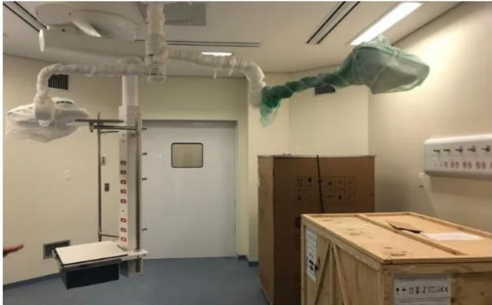
Equipamentos estão sendo instalados
