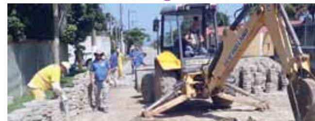
duas camadas: a primeira de bica corrida (material composto por pedra e cascalho), e acima uma camada nivelada de areia para finalmente reasentar os bloquetes na via.
