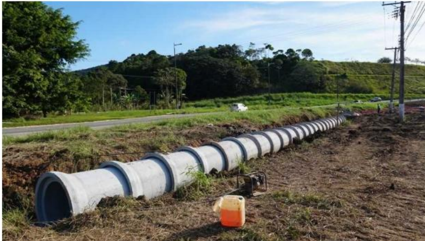
Aduelas que são instaladas próximas a Marginal Jetuba
