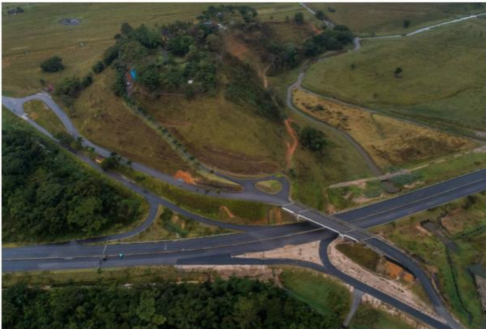
Viaduto que a Dersa construiu ao custo de R$ 3 milhões, em Caraguatatuba (SP) - Eduardo Anizelli/Folhapress
