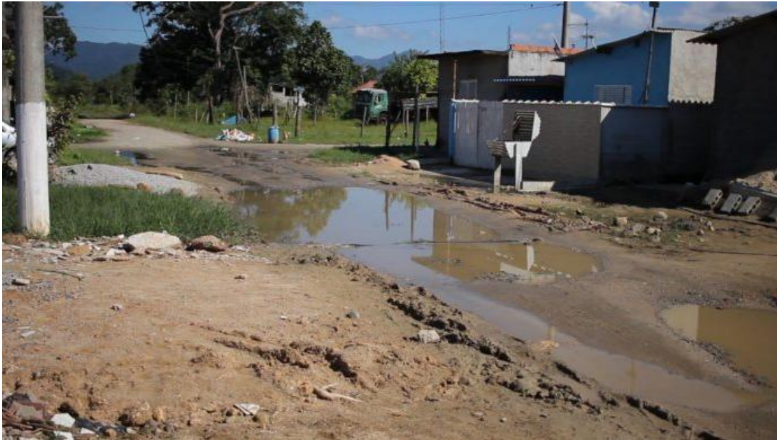
A área foi loteada sem serviços básicos de infraestrutura (Fotos: PMC/ Divulgação)
