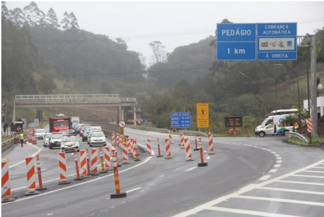
As obras de duplicação na rodovia dos Tamoios está paralisada devido a greve (Foto: Divulgação)
