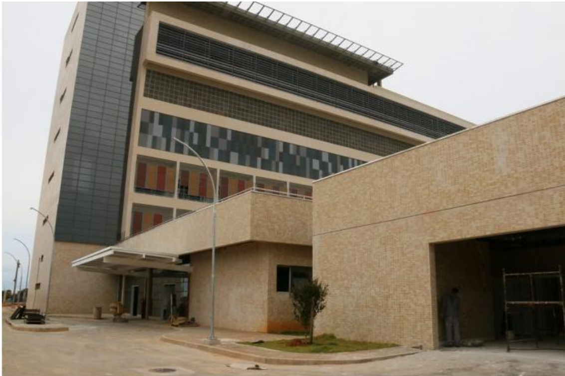
Obra do Hospital Regional está em fase de acabamento (Foto: Luis Gava/ PMC)
