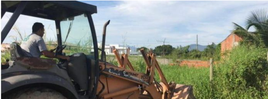
Demolição aconteceu nesta sexta-feira com apoio da PM (Foto: PMC/ Divulgação)
