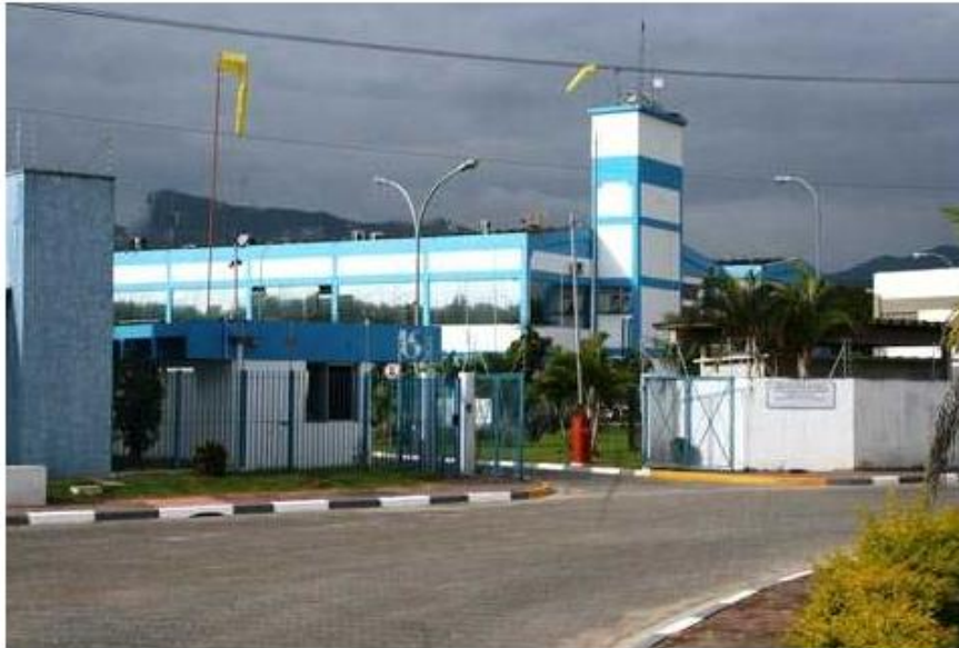
Estação do Morro Santo Antônio, em Caraguá
