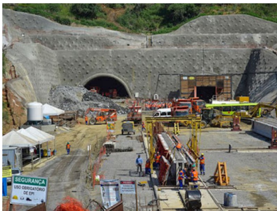
As vagas são para trabalhar em obras na rodovia dos Tamoios (Foto: Divulgação)
