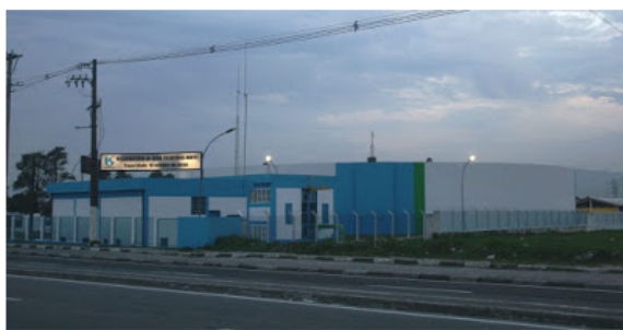
Manutenção será no reservatório Palmeiras Norte (Foto: Divulgação/Sabesp)
