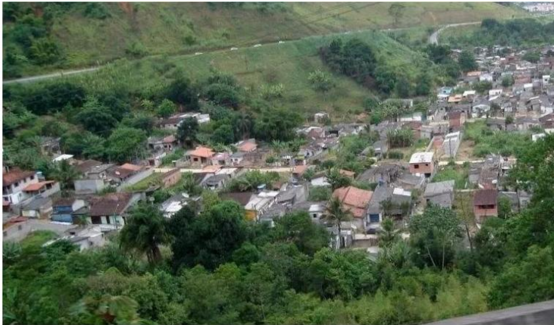
Encostas do Olaria, em caraguá, área de risco, sujeita a deslizamento.
