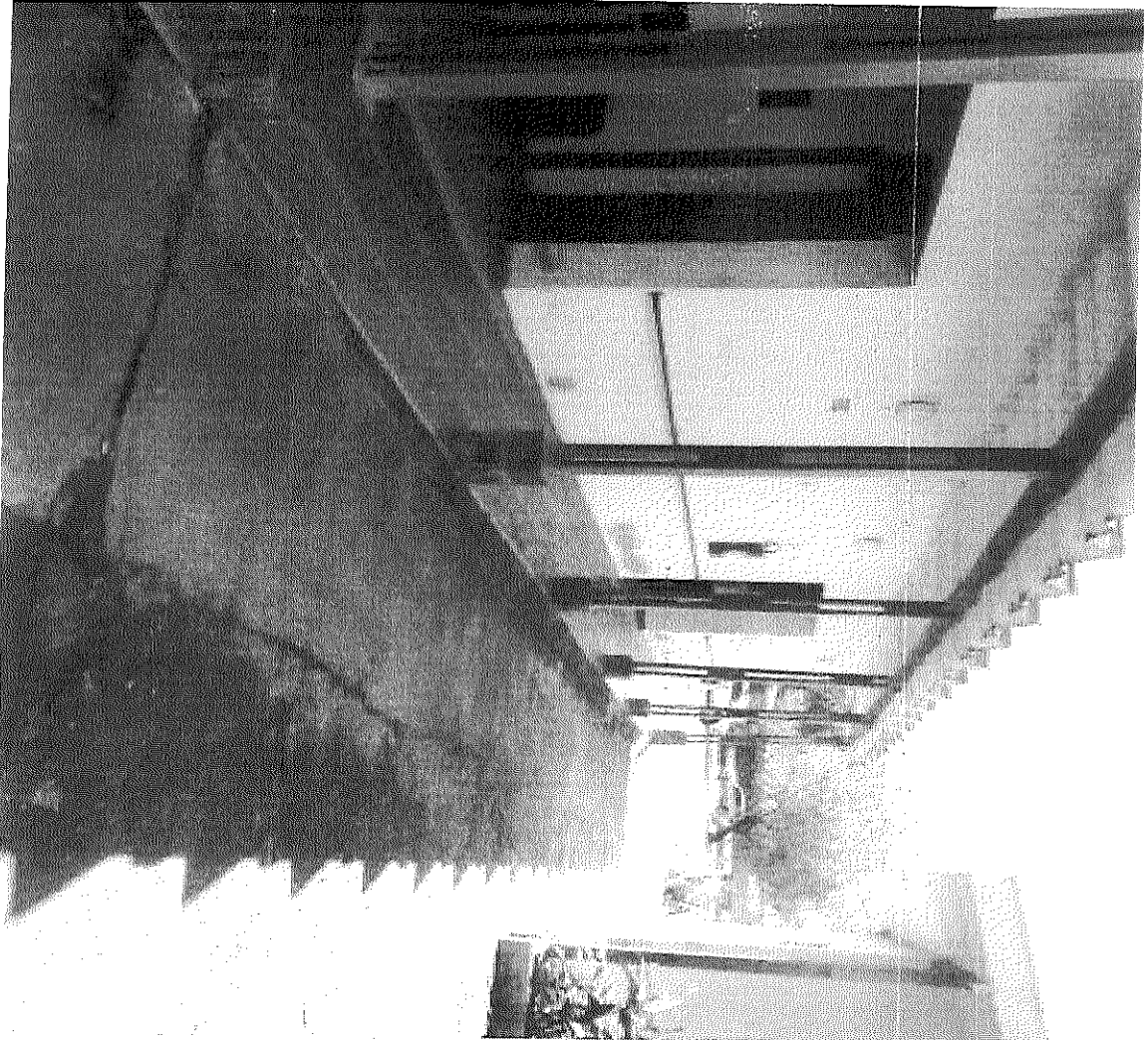
Troca de todos os esteios de sustentação do telhado por alvenaria
