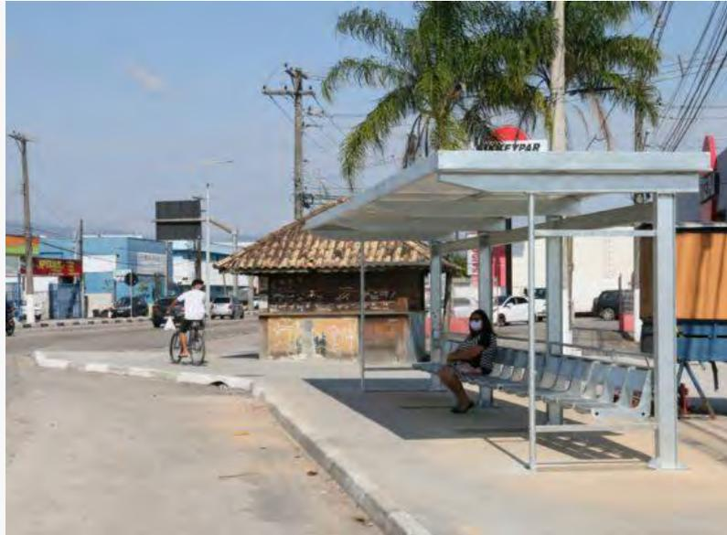
A Prefeitura de Caraguatatuba deu início à instalação dos novos abrigos em pontos de ônibus em toda a cidade. As bases já foram colocadas e agora as equipes fazem a implantação das estruturas. O próximo passo será a cobertura.
