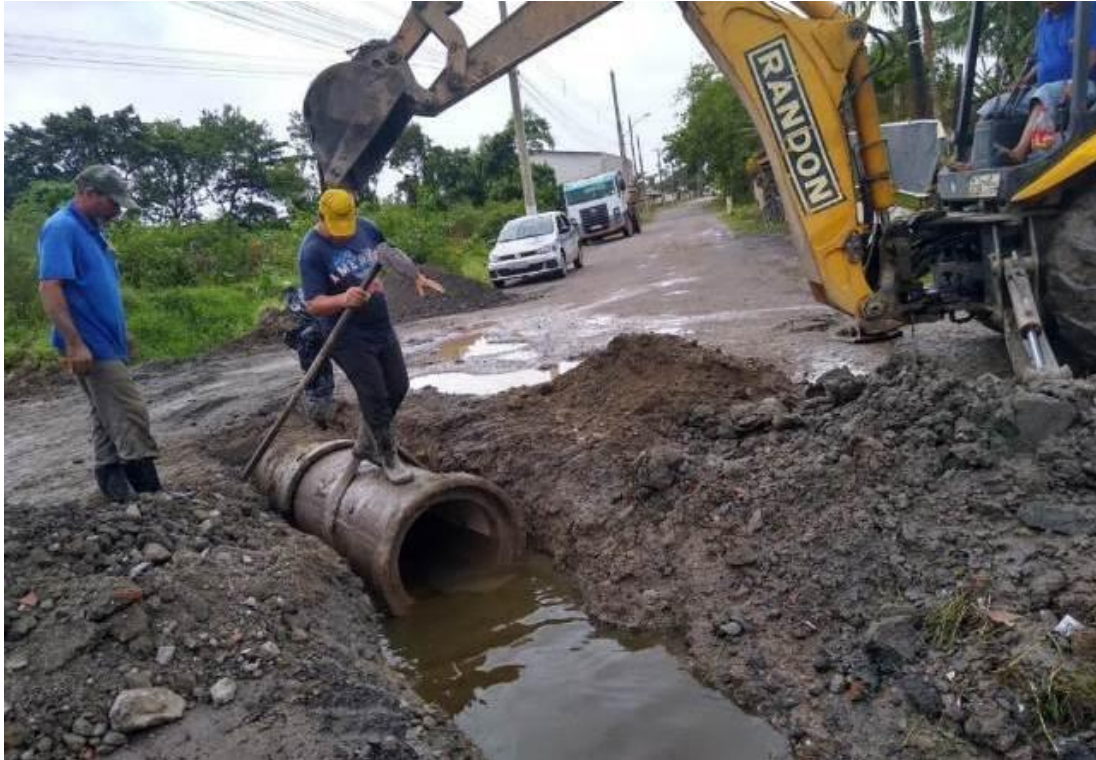
Caraguá: Nova tubulação de drenagem é instalada no Pegorelli
