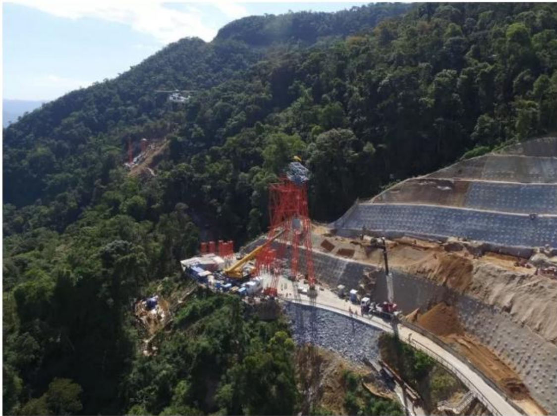
Helicóptero (ao fundo) sobrevoa área onde foram instalados pilares de sustentação do teleférico — Foto: Concessionária Tamboios/Arquivo
