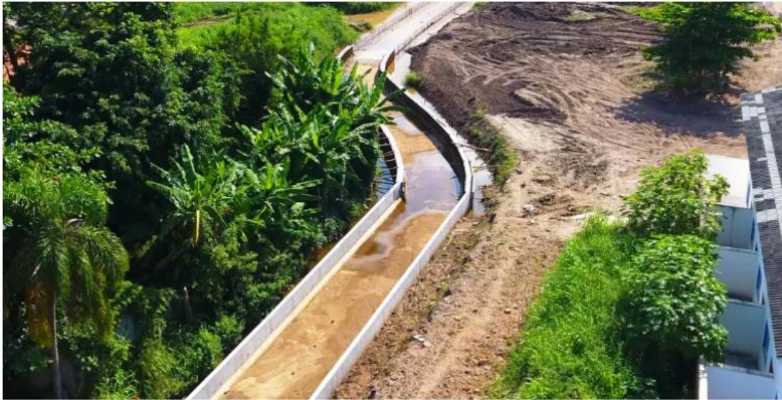
Obra que a prefeitura está executando no trecho para reduzir enchentes no bairro e rodovia
