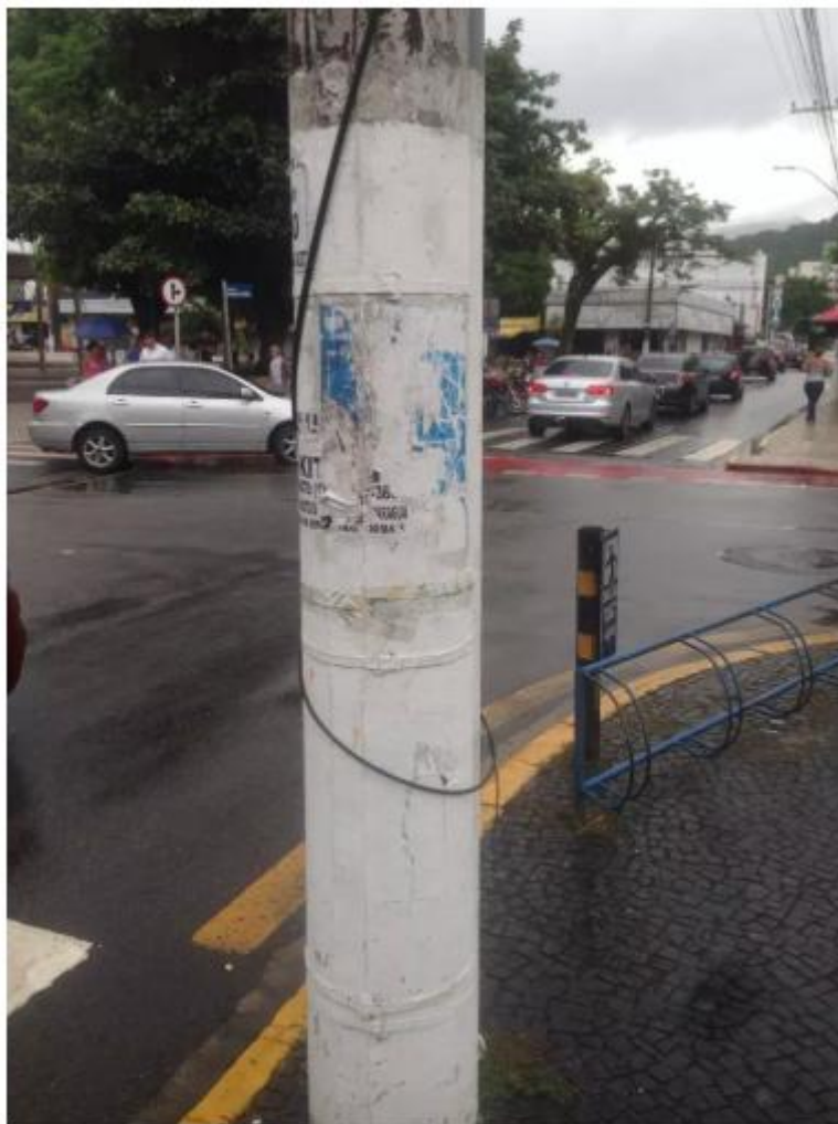
Cabo, possivelmente, de telefone, solto e amarrado em poste na praça Cândido Mota
