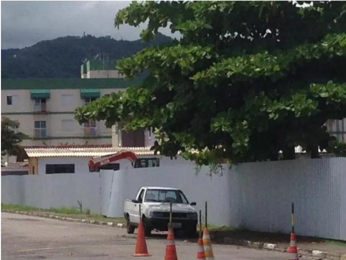
No local, apenas um alojamento, uma máquina e os tapumes
