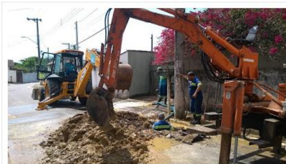
Funcionários trabalham no conserto da adutora (Foto: Divulgação/Sabesp)
