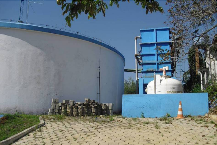
Foto 14 – Tubulação da Captação do Rio Mococa (Fonte: SABESP)
