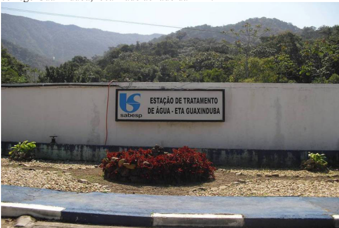
Foto 10 – Entrada da ETA Guaxinduba
