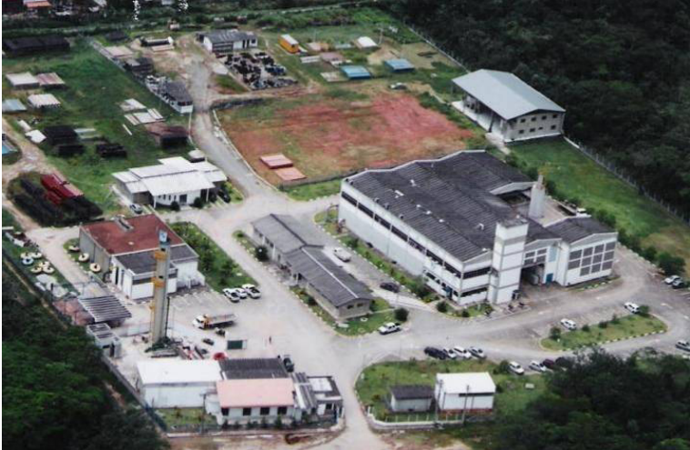
Foto 04 – Vista Geral da ETA Porto Novo (Fonte: SABESP)
