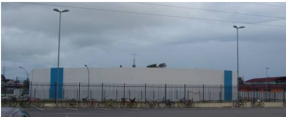
Foto 08 – Reservatório Palmeiras Norte (Fonte: SABESP)
