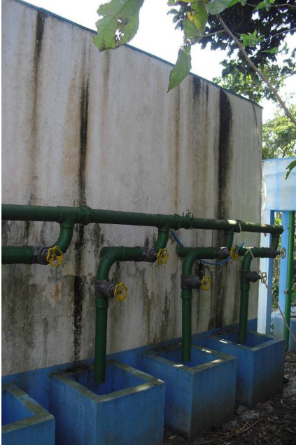
Foto 19 – Registros para lavagem dos filtros da ETA Tabatinga
