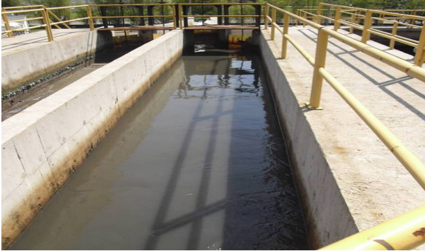
Foto 26 – Caixas de Areia da Estação de Tratamento de Esgoto Martim de Sá
