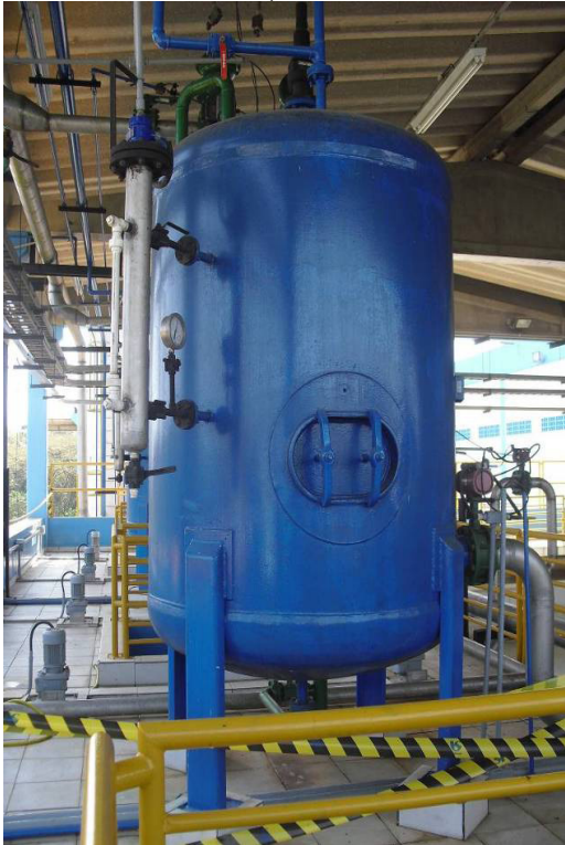
Foto 07 – Flotador por ar dissolvido
