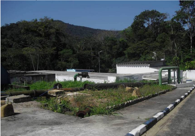
Foto 12 – Reservatório e vista geral da ETA Guaxinduba
