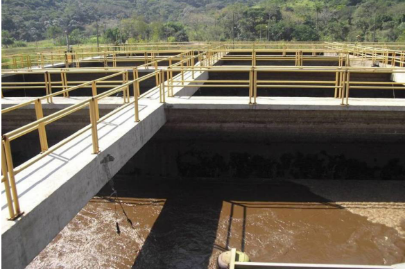
Foto 26 – Caixas de Areia da Estação de Tratamento de Esgoto Martim de Sá
