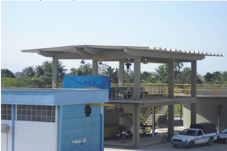
Foto 24 – Edifício de Tratamento de Lodo da ETE Porto Novo
