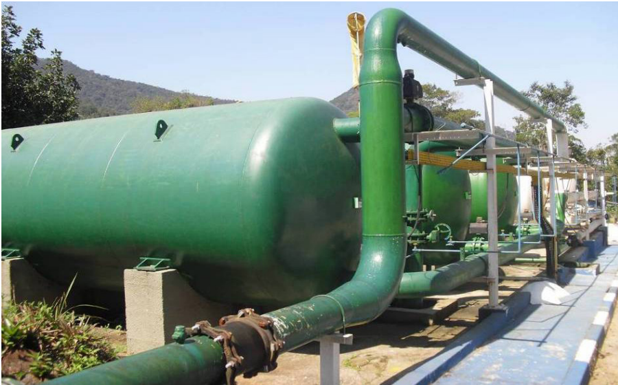
Foto 11 – Filtros pressurizados da ETA Guaxinduba
